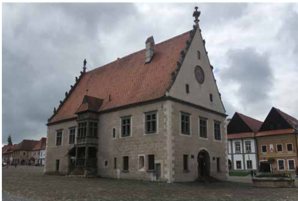
35. kép. A bártfai városháza (épült: 1505–1508)
