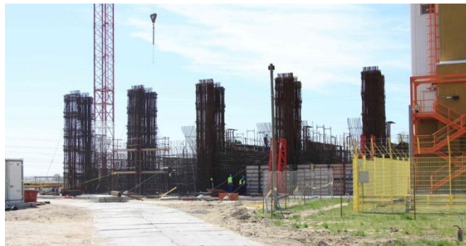
KKÁT bővítésének építési munkái
